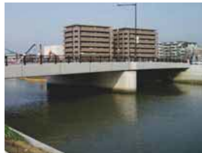
箱崎橋 改修後
