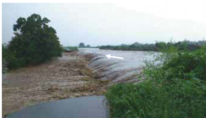
沖端川（柳川市）H24.7 集中豪雨による災害
