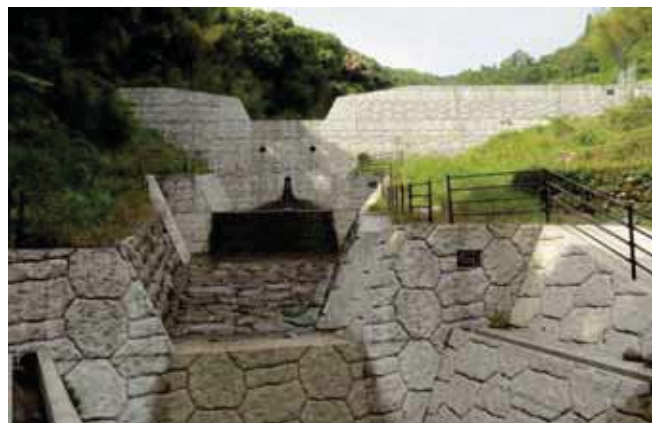
砂防堰堤（山中川 八女市黒木町）
