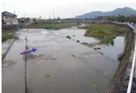
茶屋原堰 (固定堰) 平成23年11月の状況
