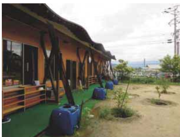
雨水タンクの設置状況
