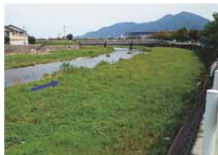
茶屋原堰 (集水埋渠) 平成27年9月の状況
