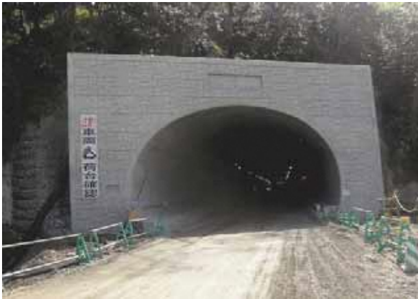
主要地方道 飯塚福岡線 見坂トンネル (宮若市、福津市)
