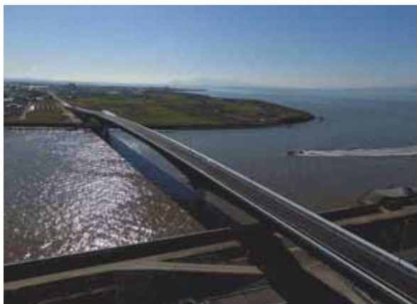
主要地方道 大牟田川副線 沖端川大橋 (柳川市)
