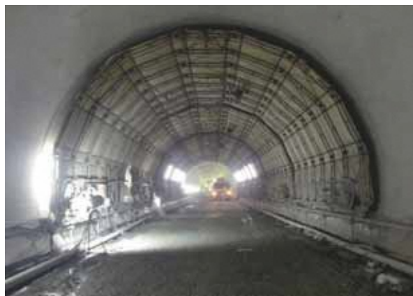
主要地方道 八女香春線 合瀬耳納工区 (八女市～うきは市)
