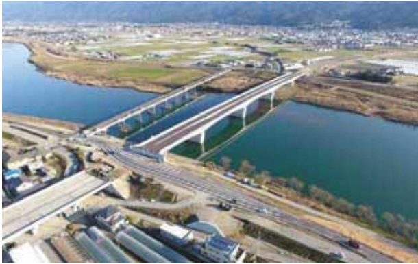
主要地方道 久留米筑紫野線 神代橋 (久留米市)
