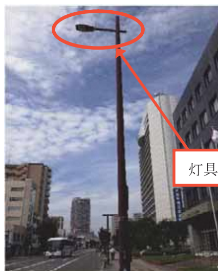
【主要地方道 久留米停車場線（久留米市）】
