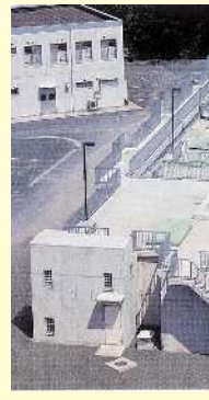
高度浄水施設
