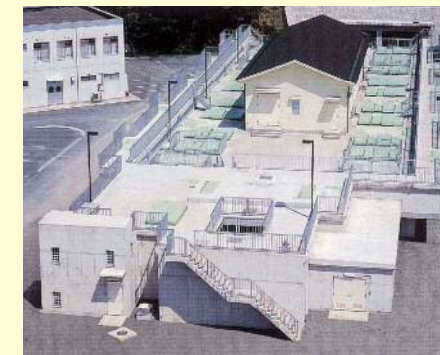
高度浄水施設(穴生浄水場)
