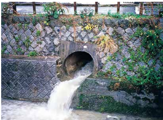
雨天時の合流式下水道の雨水吐の様子(板櫃川)
