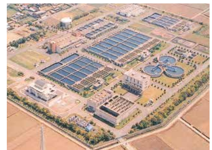
本城浄水場(昭和58年完成)
