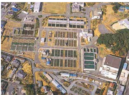
穴生浄水場(昭和36年完成)
