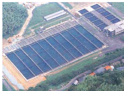
井手浦浄水場(昭和47年完成)
