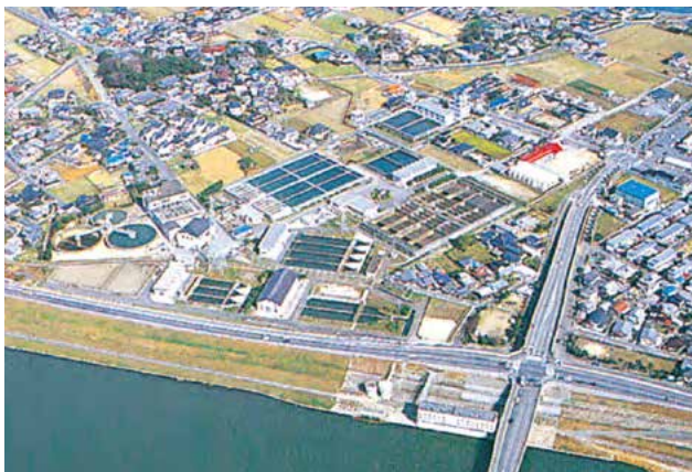
伊佐座取水場(昭和19年完成)
