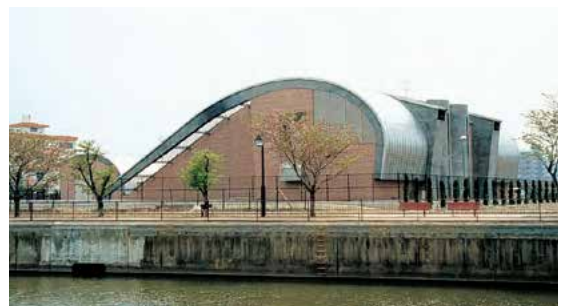
金山川ポンプ場
