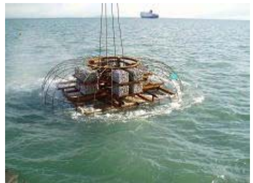
増殖場設置工事の様子
