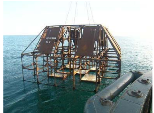
魚礁設置工事の様子
