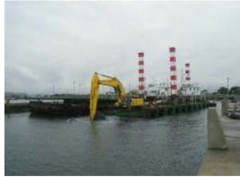
泊地浚渫（吉富町・吉富漁港）
