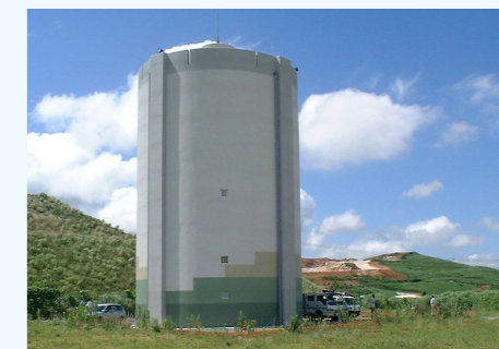
平尾台配水池
