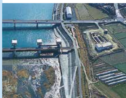
平成大堰 平成 2年度完成
