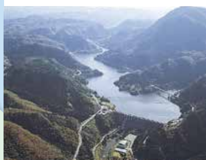
耶馬溪貯水池 昭和60年度完成
