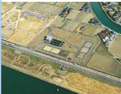
猪熊取水場 昭和57年度完成
