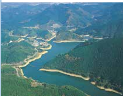
力丸貯水池 昭和40年度完成
