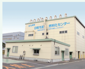
日明汚泥燃料化センター
