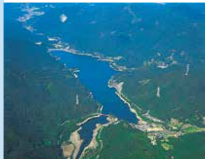
油木貯水池 昭和46年度完成
