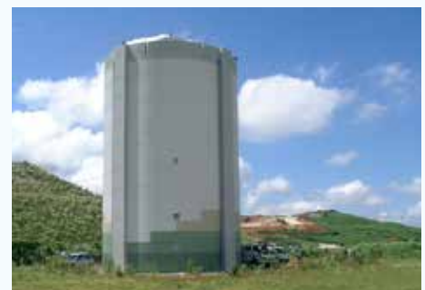
平尾台配水池
