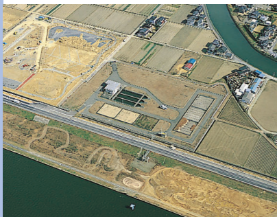
猪熊取水場 昭和57年度完成
