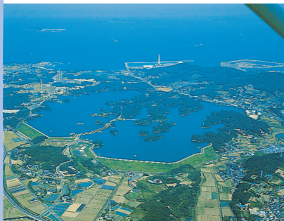
頓田貯水池 第1貯水池 昭和26年度完成 第2貯水池 昭和33年度完成
