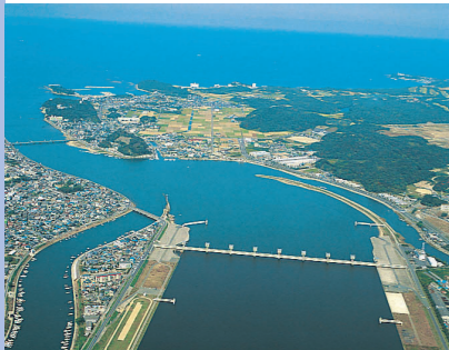
遠賀川河口堰 昭和57年度完成
