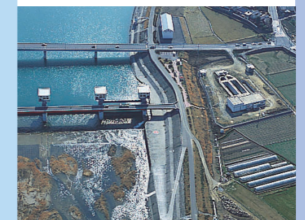
平成大堰 平成2年度完成
