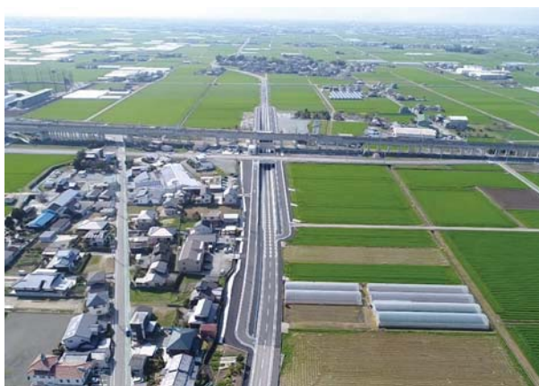
一般県道 柳川筑後線 筑後市工区 (筑後市)
