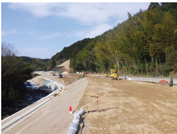
一般国道 322 号 千手バイパス (嘉麻市)
