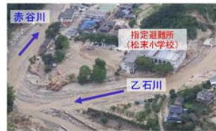
土砂・流木により被災した避難所
