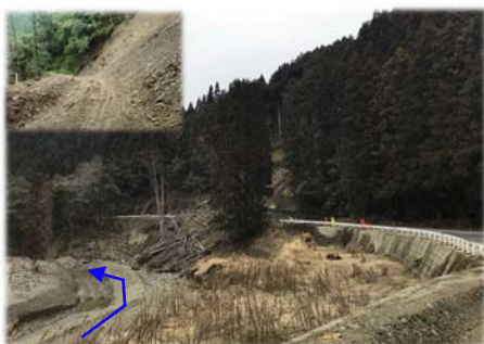
道路啓開状況
