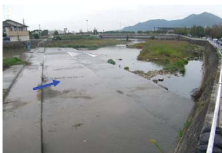
茶屋原堰 (固定堰) 平成23年11月の状況
