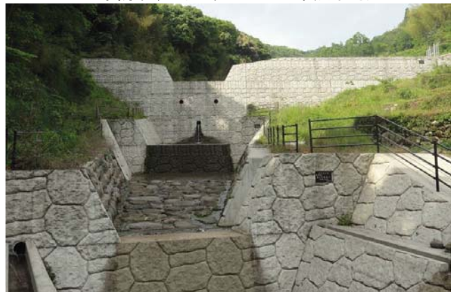
砂防堰堤 (山中川 八女市黒木町)
