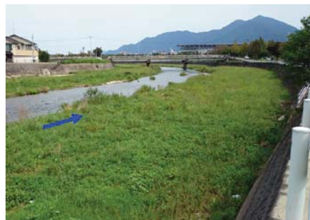
茶屋原堰 (集水埋渠) 平成27年9月の状況
