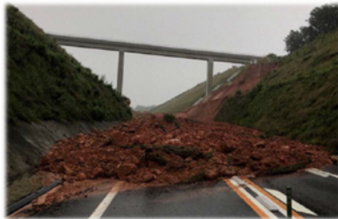
[暫定2車線区間] 東九州自動車道
