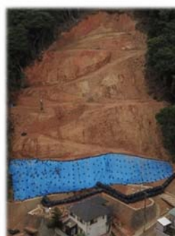
応急復旧状況
