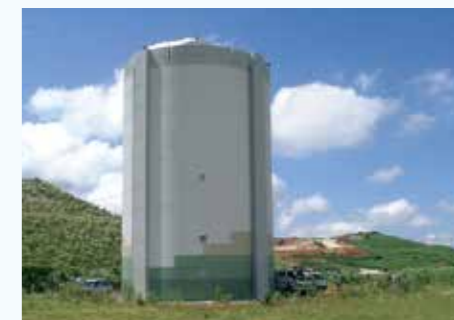
平尾台配水池
