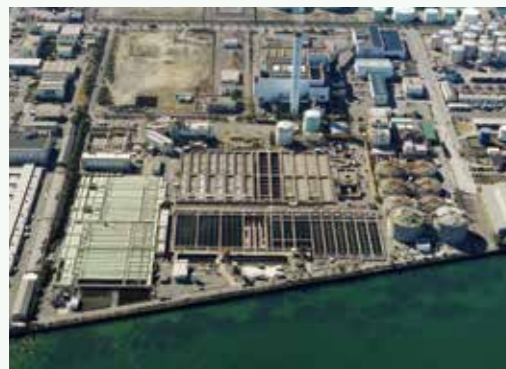
日明浄化センター - 昭和45年完成 -
