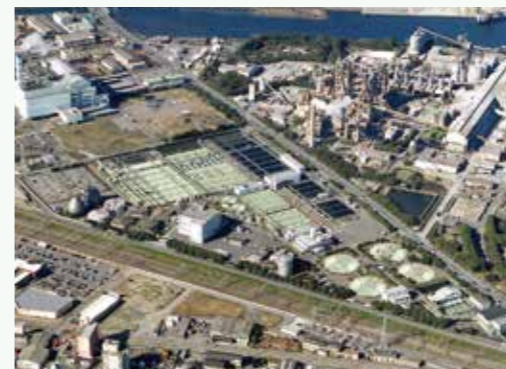
皇后崎浄化センター - 昭和38年完成 -
