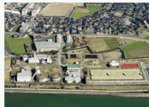
曽根浄化センター - 昭和54年完成 -
