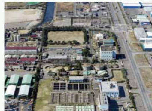
北湊浄化センター - 昭和47年完成 -
