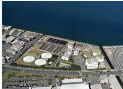
新町浄化センター - 昭和47年完成 -
