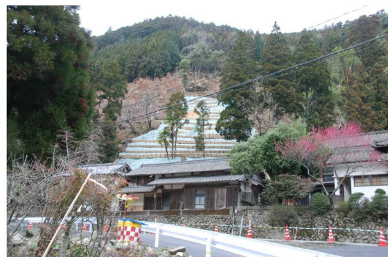
山崩れの再発防止のための山腹工
