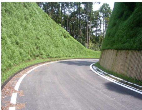
木材を利用した工法 林道 黒木・星野線 (八女市)
