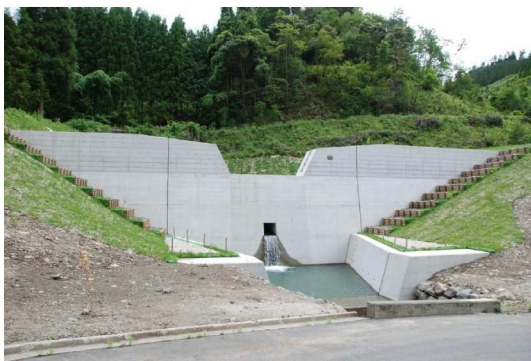
土砂の流出を防止する治山ダム工
