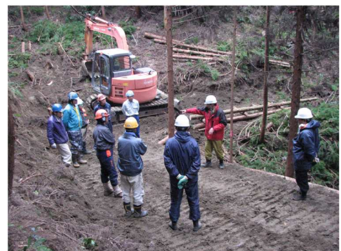
実際に森林作業道を作設し、技術を学ぶ研修生
