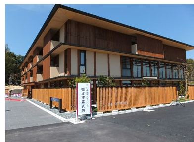
木造3階建の事例 (福岡市：九州大学伊都ゲストハウス)
