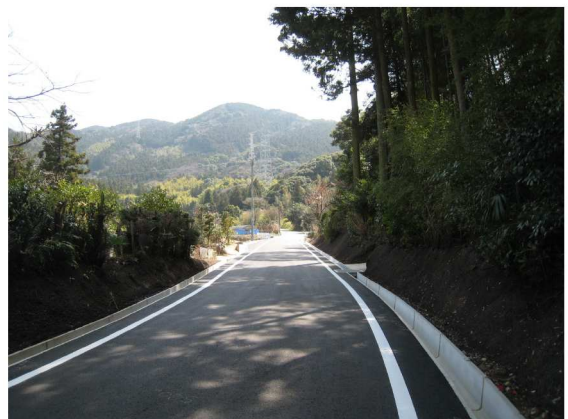
全線開通した「貫山線」林道
