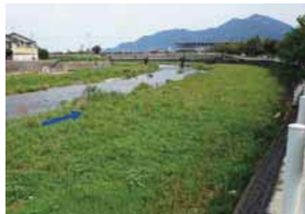
茶屋原堰 (集水埋渠) 平成27年9月の状況
