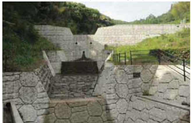
砂防堰堤 (山中川 八女市黒木町)
