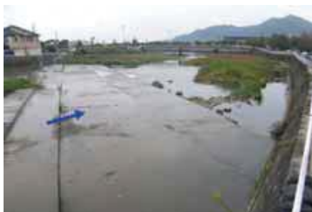
茶屋原堰 (固定堰) 平成23年11月の状況
