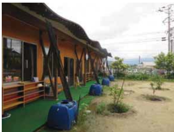
雨水タンクの設置状況
