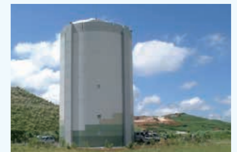
平尾台配水池
