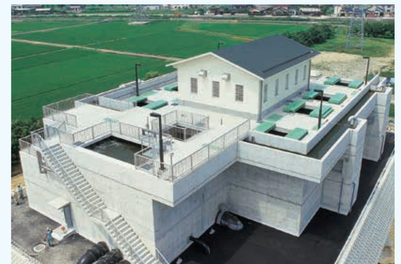
本城浄水場 上向流式生物接触ろ過池
