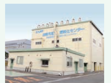
日明汚泥燃料化センター
