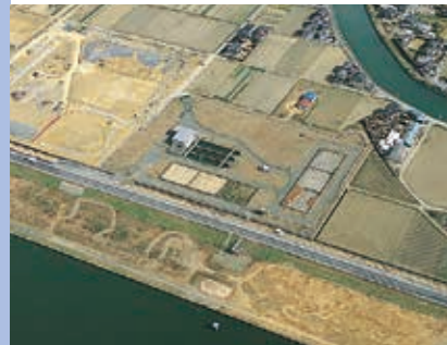
猪熊取水場 昭和57年度完成
