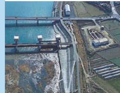
平成大堰 平成2年度完成
