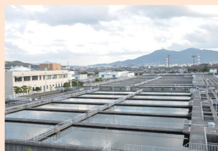
本城浄水場 沈砂池
