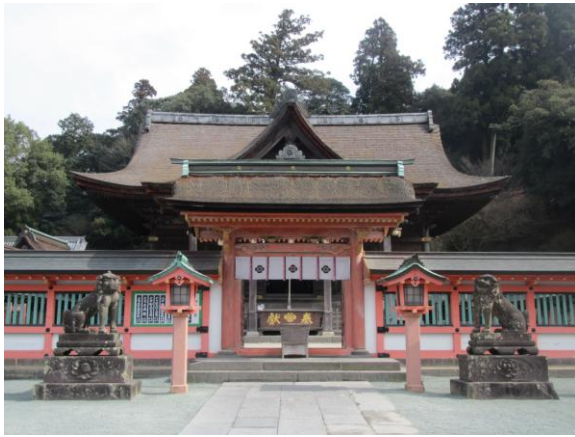
写真 1-29 ①【高良大社(本殿, 幣殿, 拝殿, 大鳥居)】 国指定
