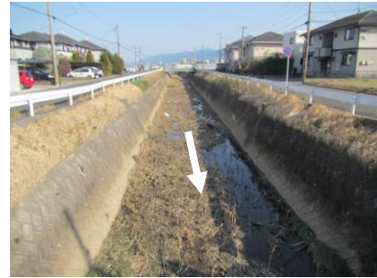
写真 1-4 小森野川全景写真
