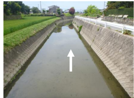
写真 1-22 大谷川全景写真
