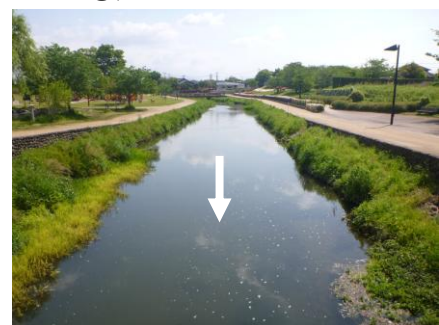
写真 1-20 大刀洗川全景写真
