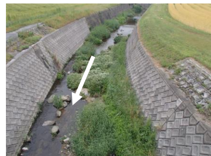
写真 1-16 原川全景写真
