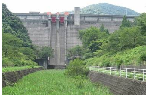
写真 2.4 ます淵ダム（昭和 48 年完成）
