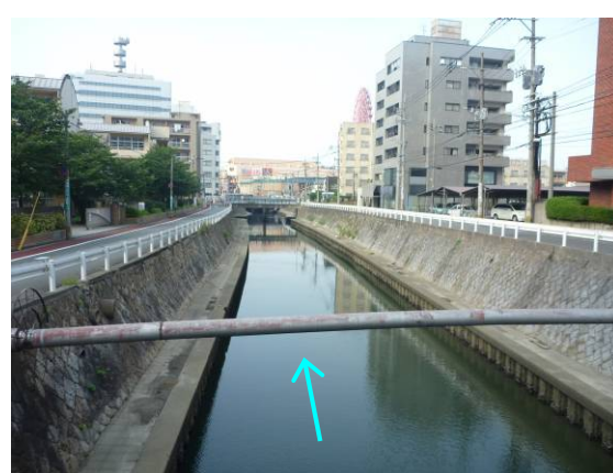
写真 1.10 砂津川 寿橋付近
