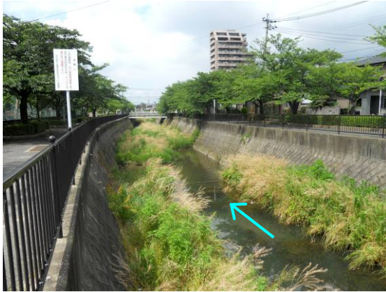
写真 1.11 志井川 徳力一号橋付近
