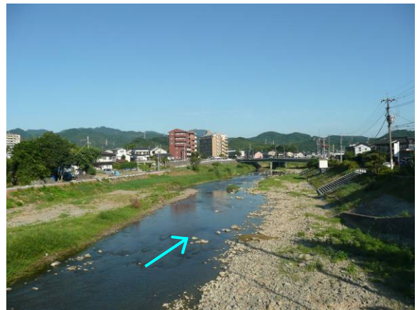
写真 1.18 紫川中流部（徳力大橋付近）
