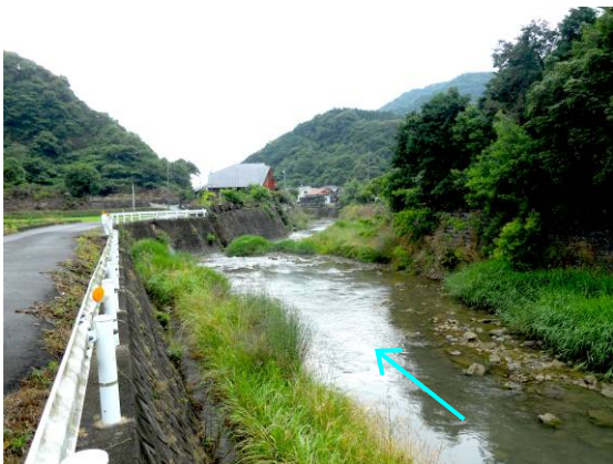
写真 1.13 東谷川 高津尾橋下流
