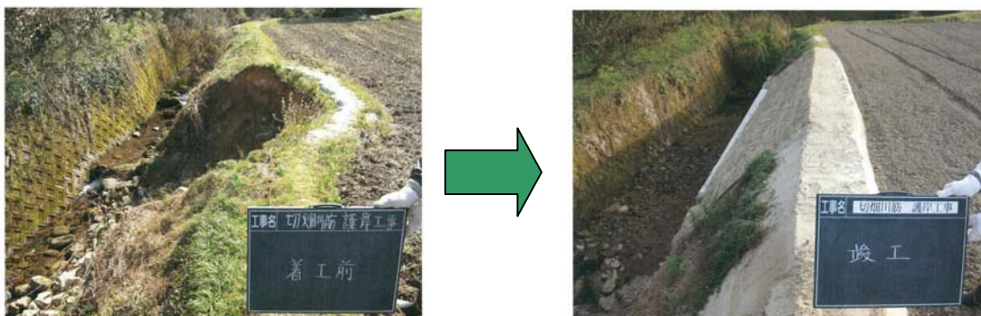
災害復旧の様子
