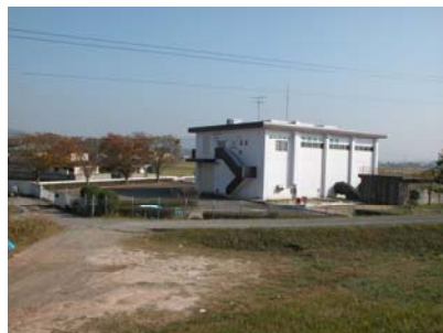
学頭排水機場(三緒浦川)
