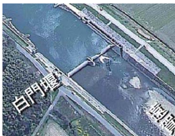
白門堰現況写真
