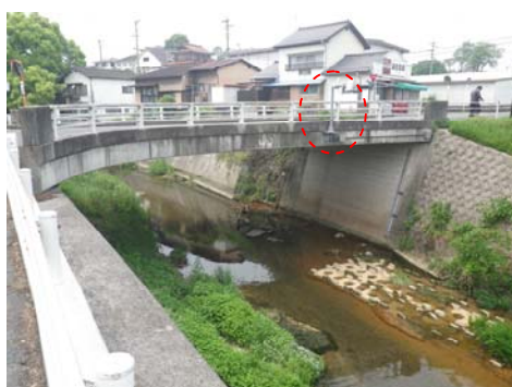
河川に設置された水位計 (テレメーター)
