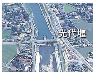
光代堰現況写真
