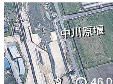
中川原堰現況写真
