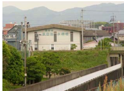
菰田排水機場(熊添川)
