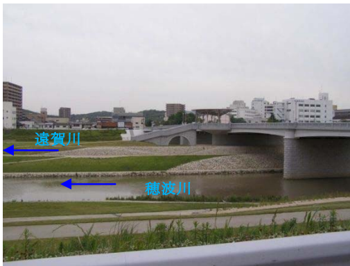
遠賀川と穂波川の合流点付近(芳雄橋)
