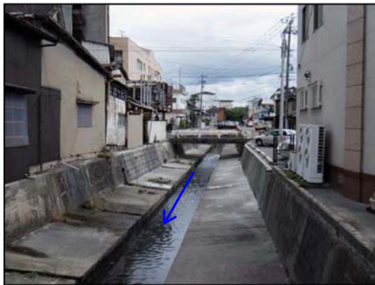
熊添川施行区間の現況写真
