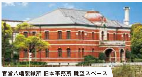
官営八幡製鐵所 旧本事務所 眺望スペース
