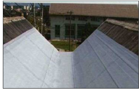
ポンプ棟屋上防水後
