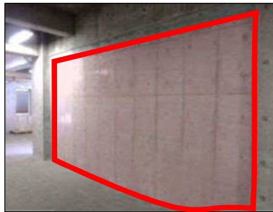
(耐震化後) 中空部に耐震壁設置
