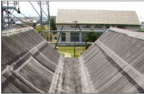
ポンプ棟屋上防水前
