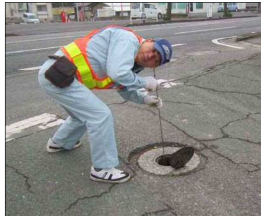
弁栓音聴調査
