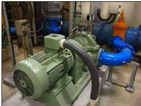
【水道】ポンプ設備の更新・適正化
