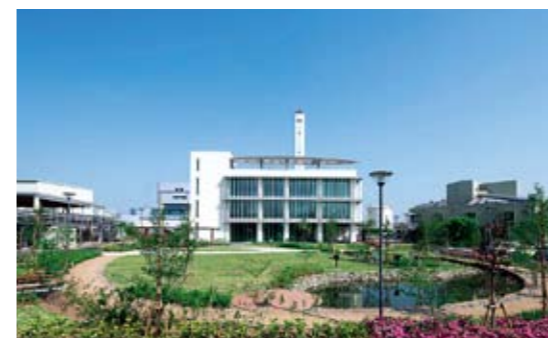
けいかん整備 (日明浄化センター)
