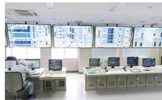
機械の運てん (皇后崎浄化センター)
