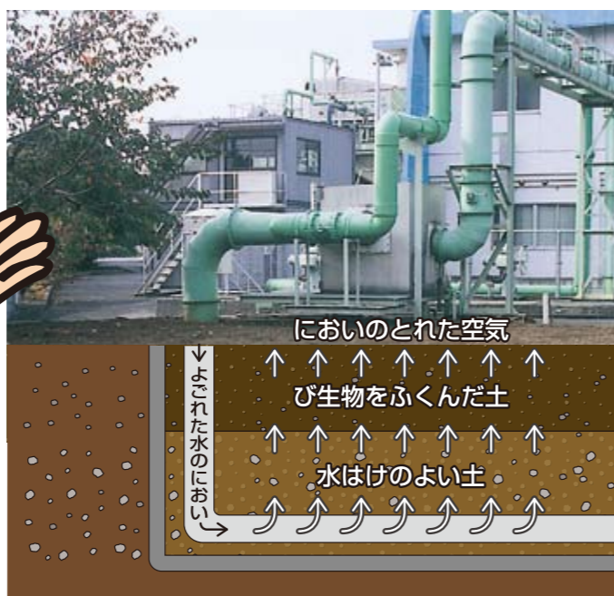
しゅう気たいさく (皇后崎浄化センター) よごれた水のおいをび生物や薬品などを使って、 とりのぞいています。
