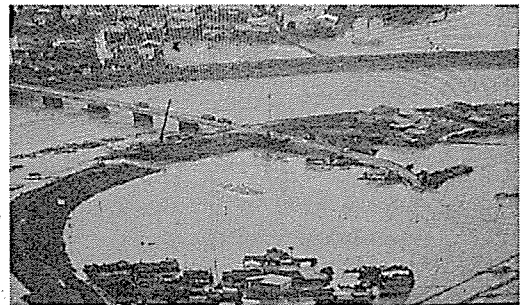
矢部川堤防決壊後の様子 (柳川市六合)
