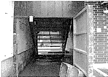
沖端川堤防決壊による被害状況 (矢印:水位の跡)
