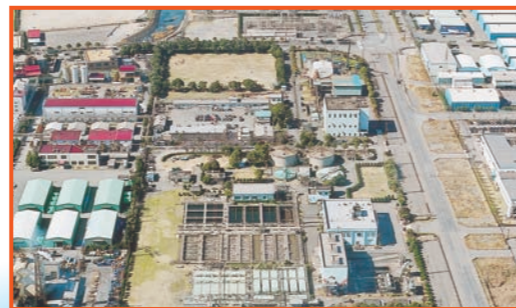
B 北湊浄化センター (若松区)
